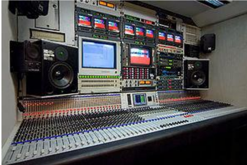
الشكل رقم (٣-١٤) نموذج من تجهيز عربة النقل الخارجي من الداخل
